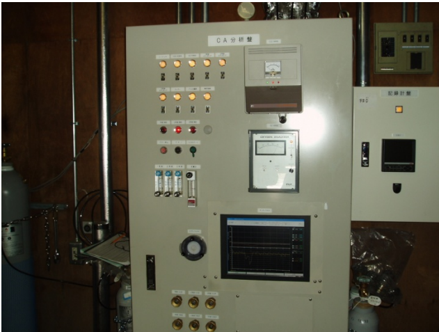
エチレンガス制御装置 (JA 士幌町の実験庫、平成 20 年 12 月 25 日)
