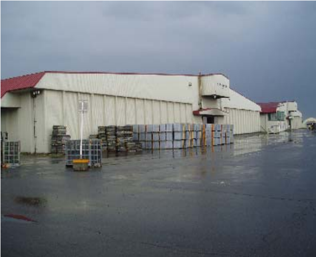
JA 士幌町の馬鈴しょ貯蔵庫 (庫内は両側に各4室に分かれており、全体で約1万4千t収容可能)
