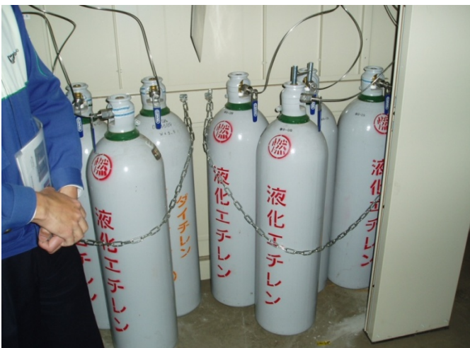
エチレンポンベ (JA 帯広かわにし、鍵のかかる部屋に保管)
